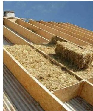
Il disposera les bottes de paille sur la surface correspondant à la zone grisée, pour créer une isolation de  $35 \text{ cm}$  d'épaisseur.
